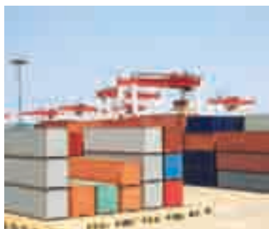
Монтаж электропроводки в судостроении и охлаждении контейнеров.
